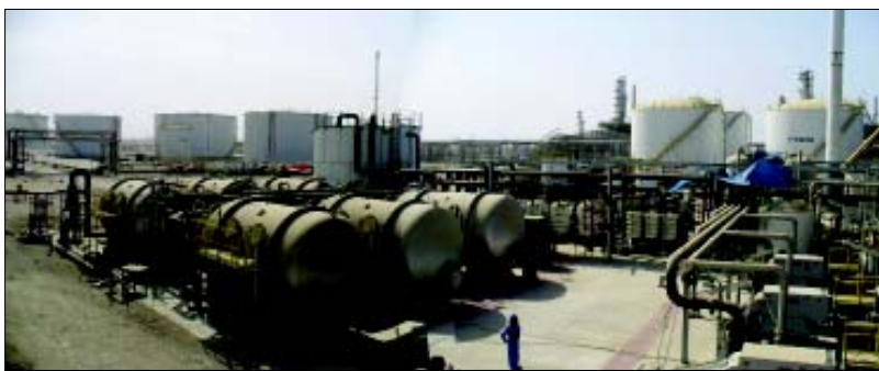
盛康最近在阿曼为 Sohar 炼油厂建设了一家 3 万 \text{m}^3/\text{d} 的海水淡化厂。
